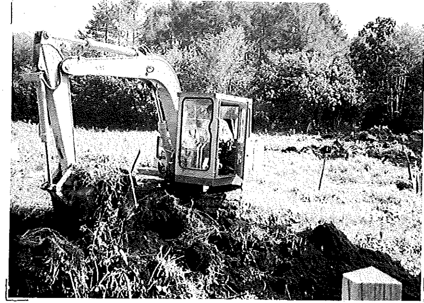
○ 表土剝離作業
